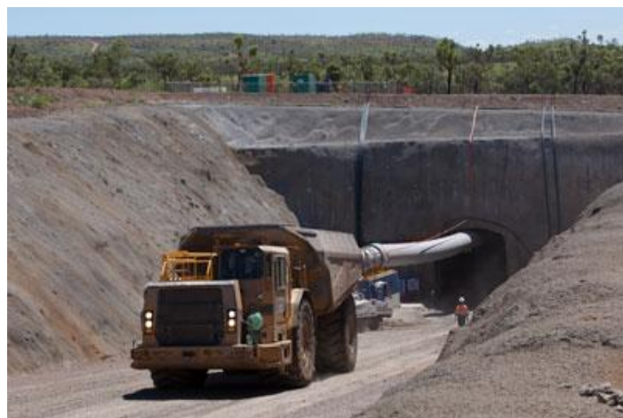
Schrägschacht Zinkbergwerk Dugald River
