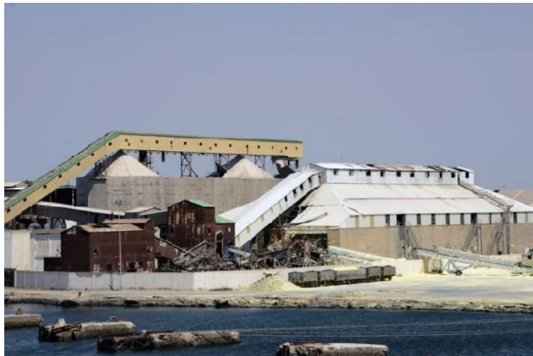
Phosphataufbereitung in Tunisia
