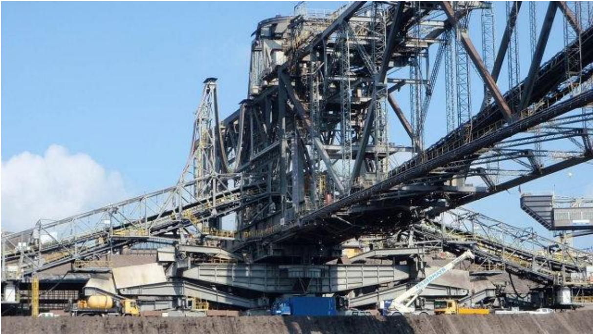
Förderbrücke F60 – Große Schwinge
