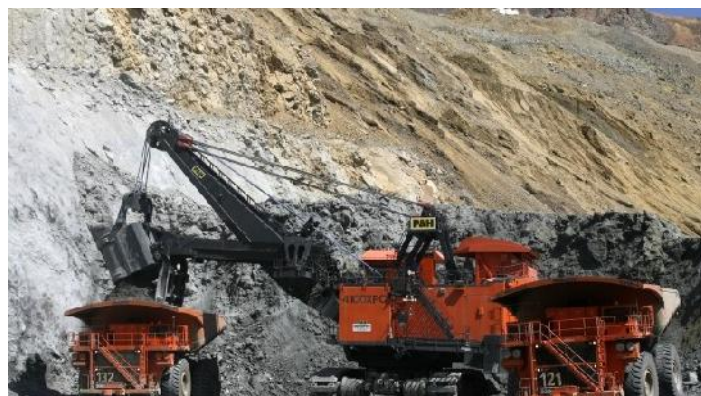
Vorbereitende Arbeiten im Tagebau Mirador
