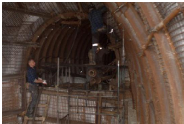
Arbeiten im Schrägschacht
