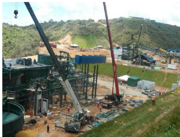
Bau der Aufbereitung
