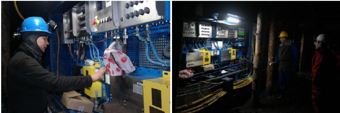
Neue Strebausrüstung auf dem Bergwerk Kakanj
