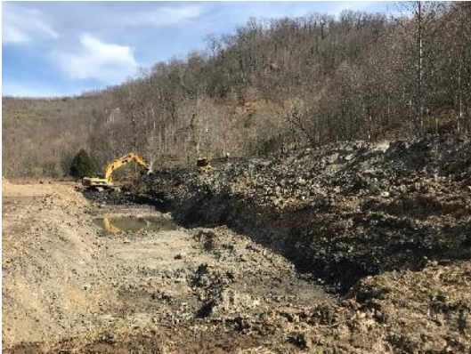
Vorbereitende Arbeiten für das Bergwerk Carnegie 2
