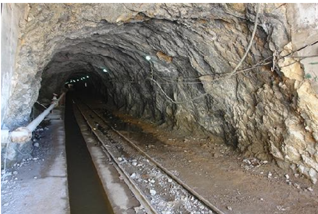
Zugangsstollen Bergwerk Angouran
