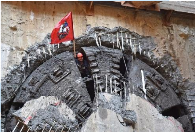
TBM - Durchschlag
