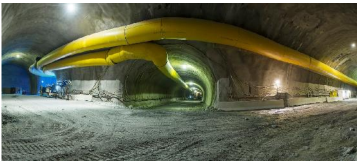
Abzweig im Brennerbasistunnel
