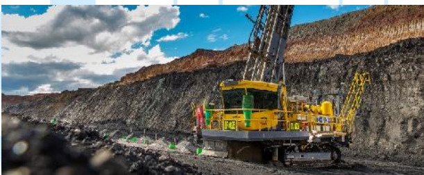
Bohrgerät der Action Drill & Blast
