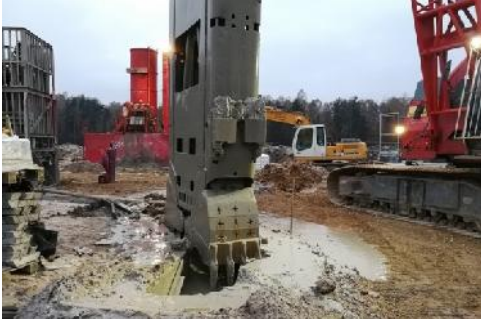
Erstellen der Schlitzwände
