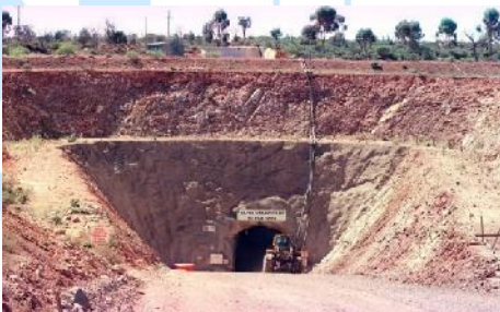
Schrägschacht Bergwerk Silver Swan
