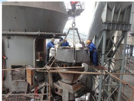
Reparatur im Zementwerk Tan Quang
