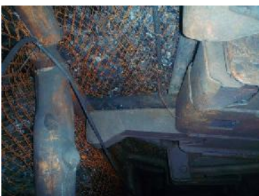
Ausbau für die Raubstellung
