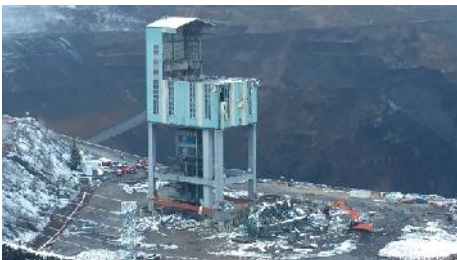
Demontage Pozo Aurelio
