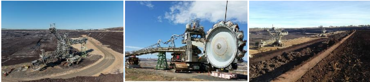
Demontage Großgeräte Braunkohletagebau Hazelwood
