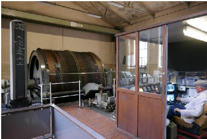
Fördermaschine Grube Fortuna
