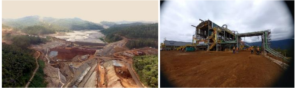
Reparatur des Damms 2017 und neue Filteranlage (samarco)
