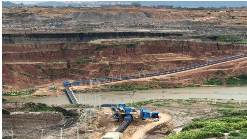
Bandanlage im Tagebau (im)
