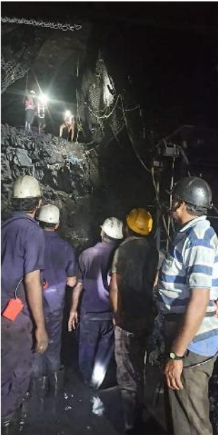
Ausbruchsbereich im Streb LC-3 (scc1)
