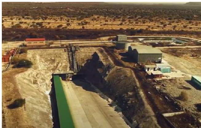
Bergwerk Maseve (rbplat)
